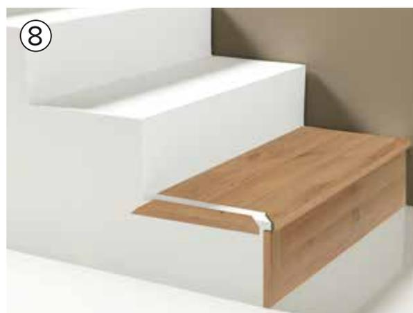
Cortar el mampelán a la medida del escalón para rematarlo. El lado derecho se corta a inglete (A) para encajar con el otro mampelán y el lado izquierdo a inglete transversal (B). Sanear la hembra y fijar al escalón con silicona.
