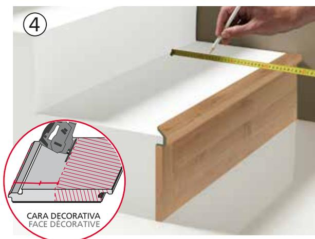
Colocar el mamperlán de forma provisional y medir la distancia (huella) del frontal al perfil. Seguidamente, cortar la pieza de suelo (dejando el decorativo hacia abajo), trasladando la medida tomada anteriormente y sumándole 2mm, contando desde el lado del macho.
