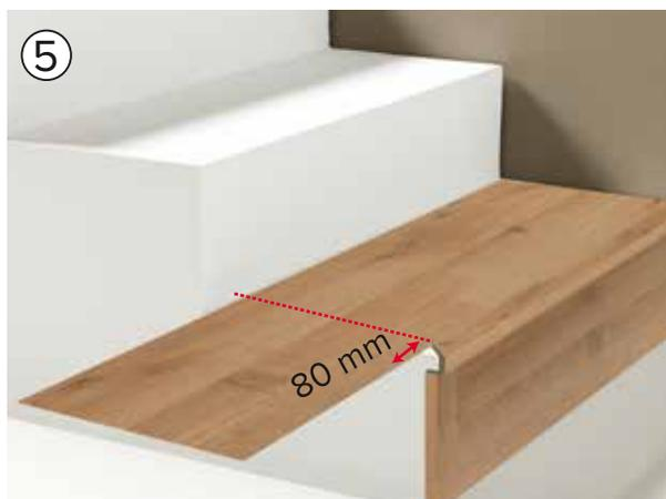
Medir el largo del peldaño restándole de nuevo la medida del mampelán (80mm) y cortar la pieza de suelo por ambos lados a medida, de forma que se saneen el macho y la hembra.
